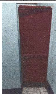
Foto 11: Sustrucción de puerta en servicios sanitarioa
