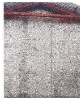
Foto 6: Pintura en muros exteriores e interiores
