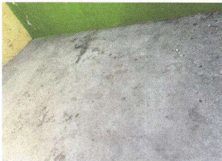
Foto 3: Sustrucción de piso granito
