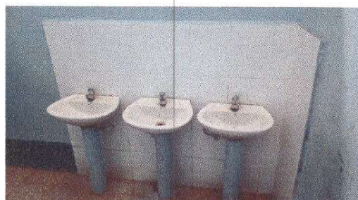
Foto 10: Sustrucción de lavamanos
