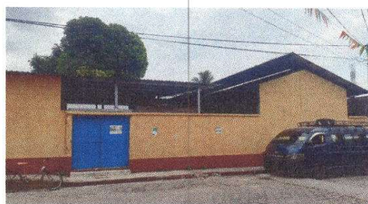
Foto 12: Pintura en muros exteriores e interiores
