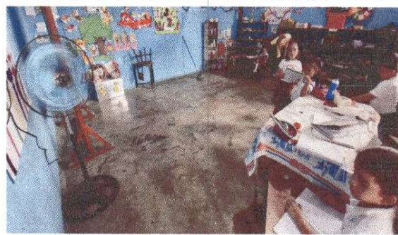
Foto 8: Sustrucción de piso granito
