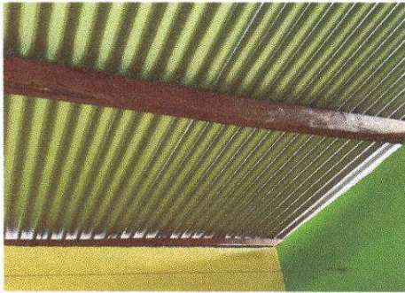
Foto 1: Sustrucción de lámina, por lamina troquelada aluzinc calibre 26
